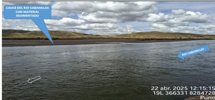
FIGURA 1 y 2: TRAMO CRÍTICO EN EL RÍO CHICO CABANILLAS, EN EL SECTOR CAMBRACA YOCARA, DISTRITO DE JULIACA, PROVINCIA DE SAN ROMÁN- PUNO. NOTESE, LA ACUMULACION DE MATERIAL SEDIMENTADO EN EL CAUCE, QUE REQUIERE SER ELIMINADO PARA REESTABLECER LA SECCIÓN HIDRAULICA DE LA CAJA DEL CAUCE EN ESTE SECTOR.
